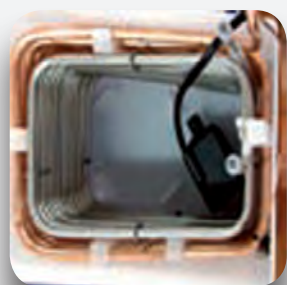
Sistema refrigeración banco de hielo.
